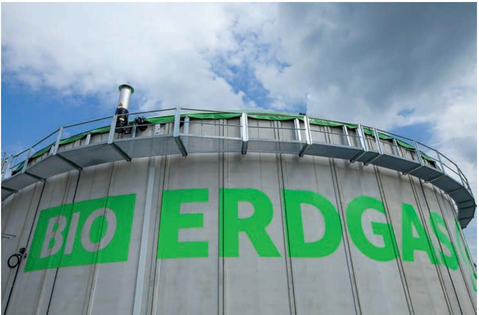
In den Biogasanlagen (BGA) wird im Rahmen einer anaeroben Fermentation aus Silagen nachwachsender Rohstoffe (Zuckerrüben, Mais, Gras, Ganzpflanzensilagen) energie-reiches Biogas erzeugt. Dieses wird in den integrierten Niederdruckgasspeichern der Behälterdächer zwischengespeichert und biologisch entschwefelt. Die eingesetzten Substrate (Silagen) werden durch Landwirte in der näheren Umgebung bereitgestellt.
