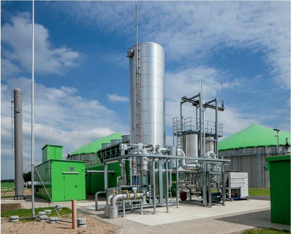
Die Gasaufbereitung arbeitet nach dem Prinzip der drucklosen Aminwäsche, wobei im Wesentlichen das im Biogas enthaltene Kohlenstoffdioxid entfernt wird. Die BHKW erzeugen in Kraft-Wärme-Kopplung Strom und Wärme, welche zu großen Teilen wiederum in der Regenerationsstufe der Gasaufbereitung verwendet wird.
